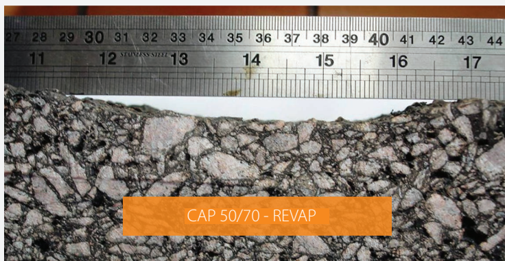
Figura 1: Foto da deformação permanente da mistura com CAP 50/70.
